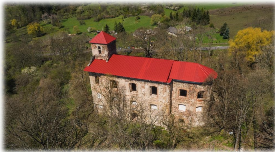
Kostel Nanebevzetí Panny Marie, třetí etapa – rekonstrukce střechy a krovu
